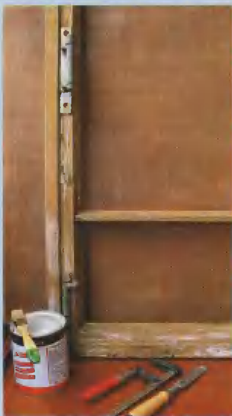
Рис. 2. Ремонт шипового соединения бруса обвязки
